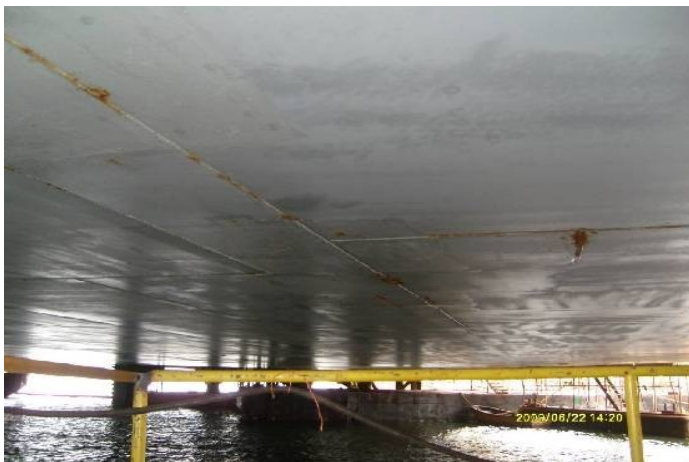
Dno przed remontem
