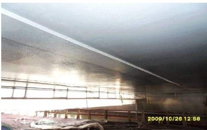
Dno po aplikacji nowej powłoki antykorozyjnej
